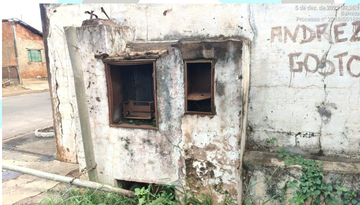
Figura 20 - Cavalete e padrão de entrada elétrico ausentes
