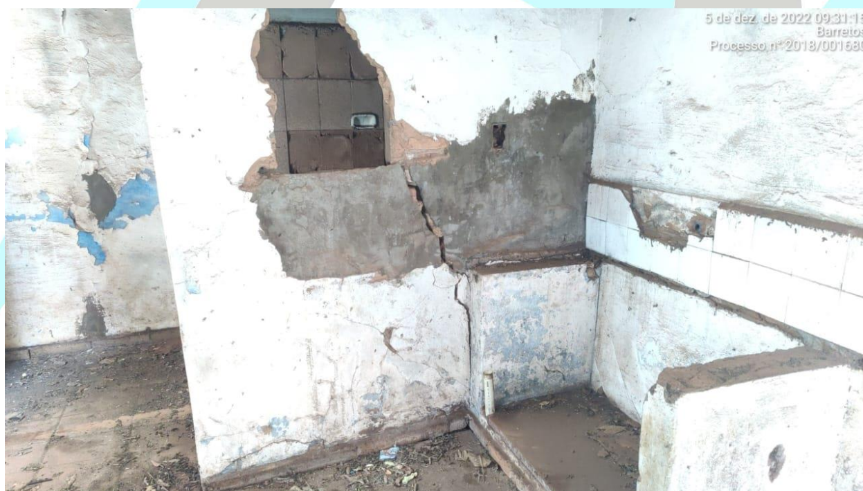
Figura 12 - Alvenaria com rachaduras
