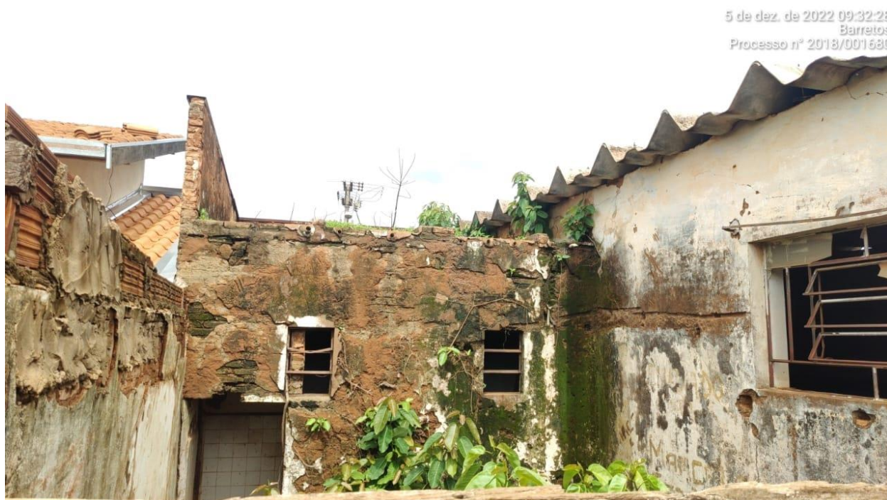
Figura 13 - Pontos de demolição por colapso na alvenaria
