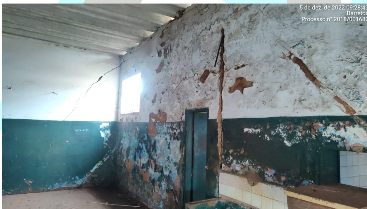
Figura 10 - Paredes internas com pontos avançados de infiltração
