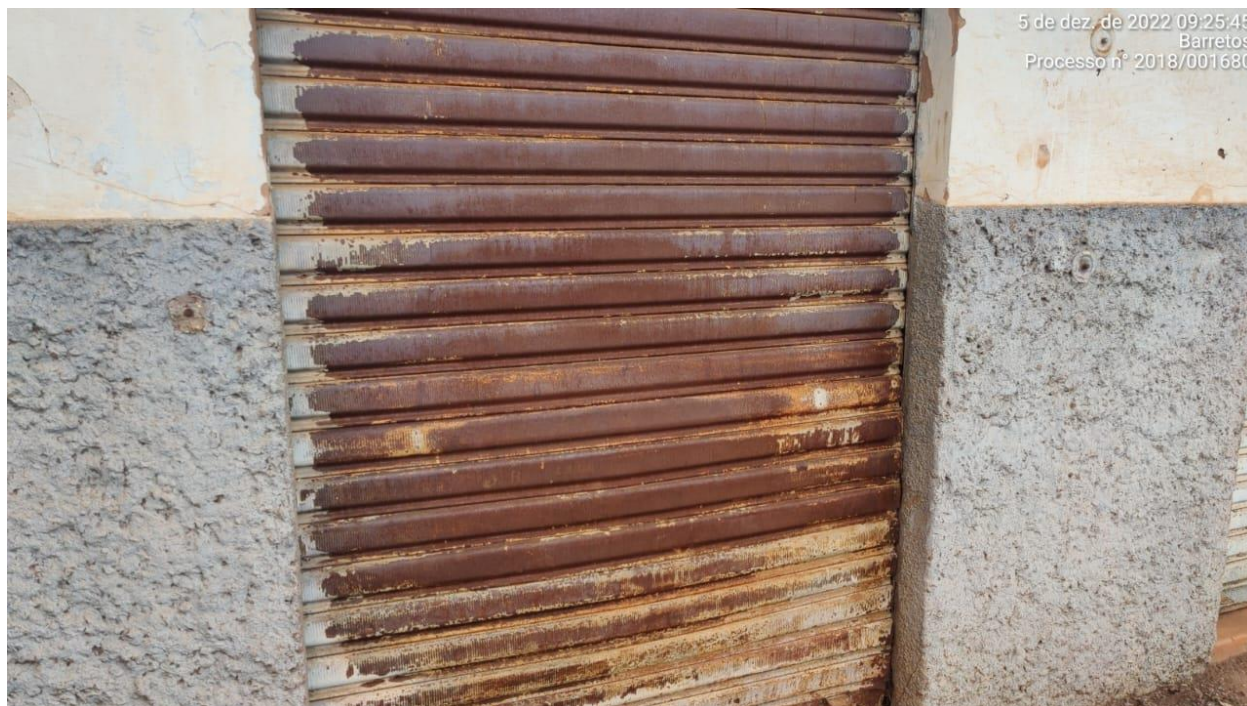
Figura 9 - Porta de aço em estado avançado de oxidação
