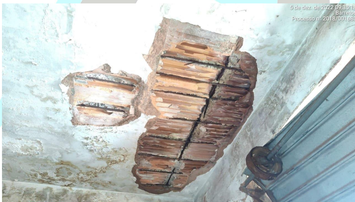
Figura 14 - Armadura da laje com pontos avançado de oxidação, risco eminente de colapso
